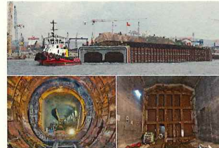
沈埋トンネルの施工
