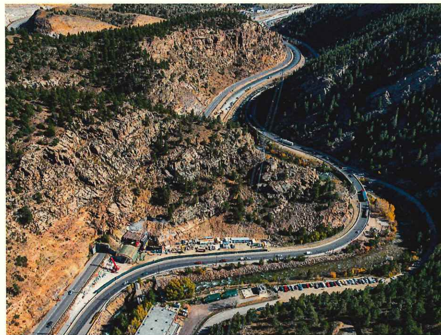
東行き施工状況
