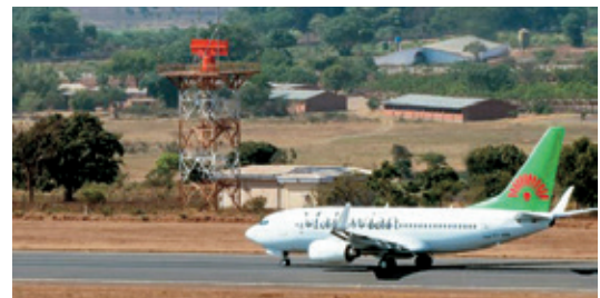
新たに設置したレーダー（マラウイ） / Newly installed raider (Malawi)
