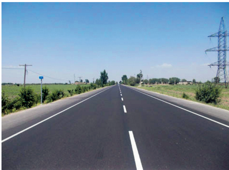
高精度施工された路面 / Road surface constructed with high precision
