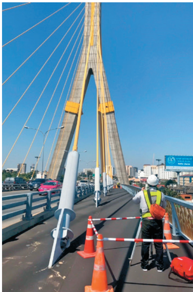
ラマ VIII 世橋のひび割れ調査 / Crack Inspection of King Rama VIII Bridge
