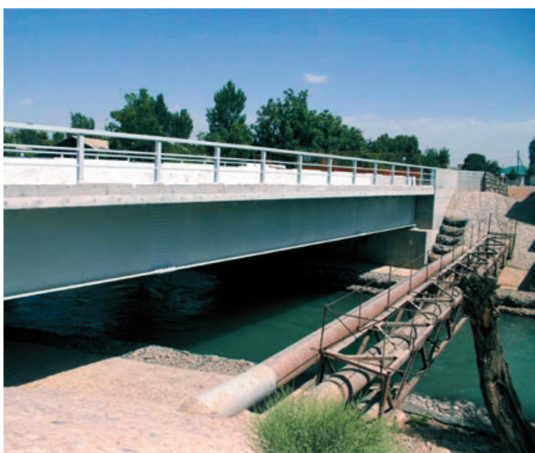
橋梁部 / Bridge part
