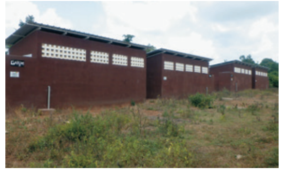
小学校に建設した公共トイレ施設 / Public restroom installed at an elementary school
