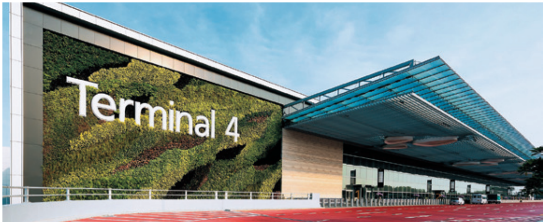
エントランス緑化壁 / Green wall at Entrance
