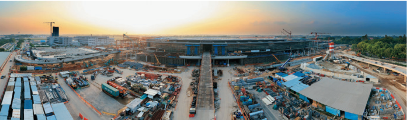
2015年8月工事中 / Construction work in progress (August, 2015)
