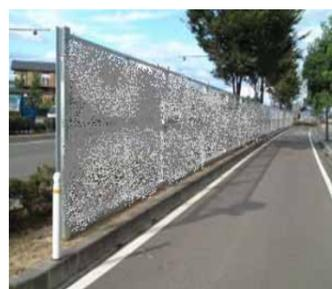
光触媒処理前: 汚れが落ちない
