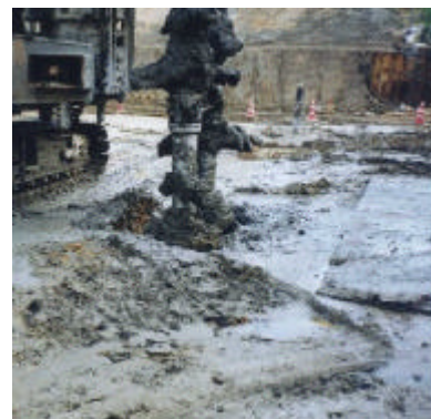
地盤改良作業状況
