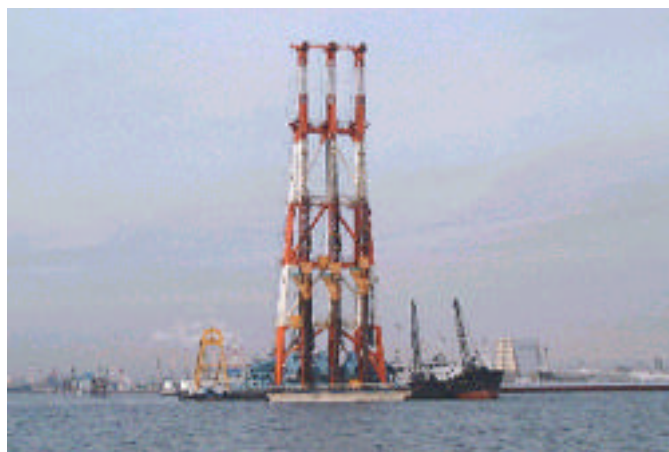
地盤改良作業状況
