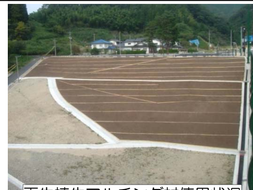
再生植生マルチング材使用状況
