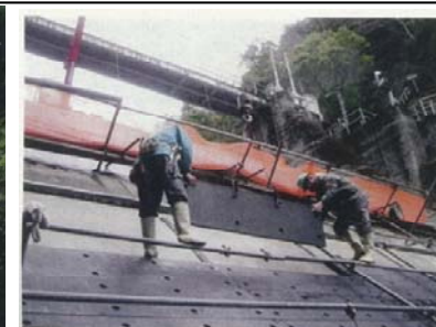
ラバーsteel 施工状況
