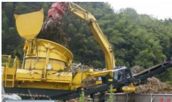
伐木材の粉碎状況
