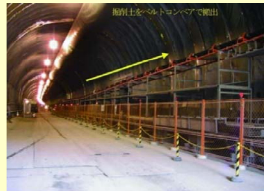
(新) ベルトコンベアによる搬出
