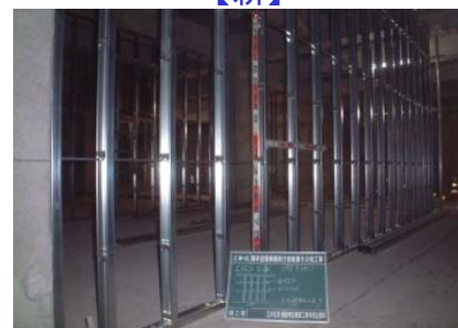
軽量鉄骨下地 ボード仕上壁
