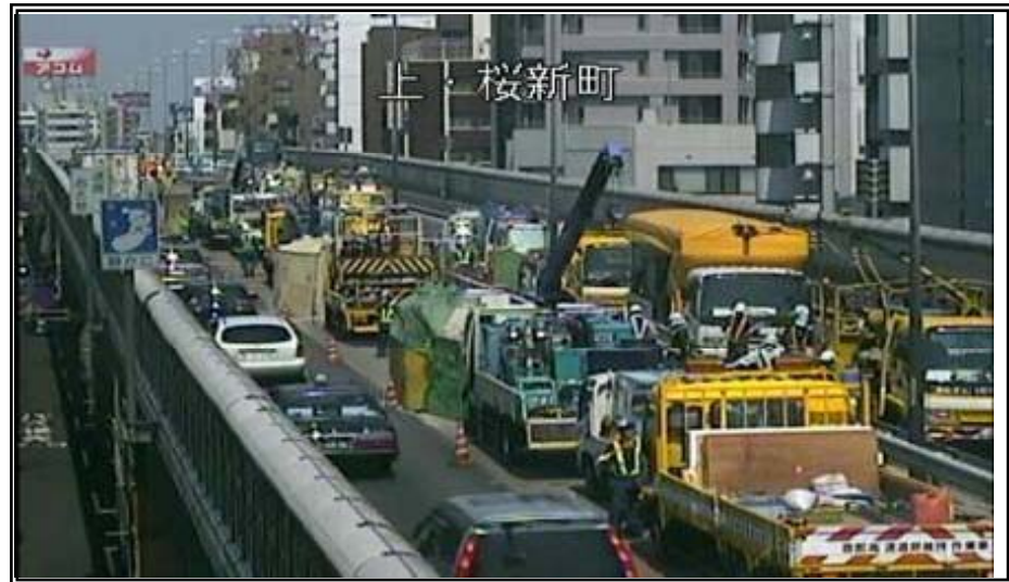
集中工事形式の施工(24時間連続規制)
