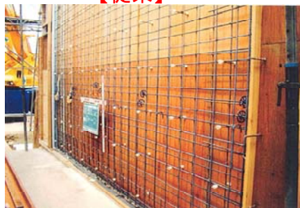
鉄筋コンクリート壁
