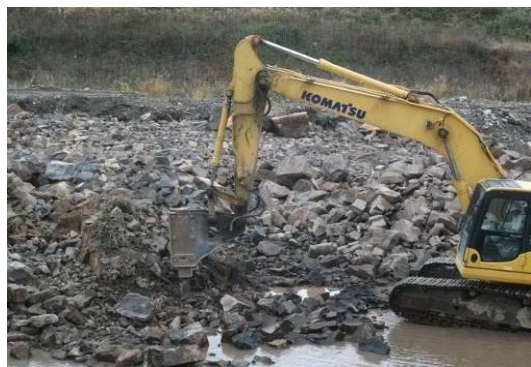
河道掘削において岩砕石が発生
