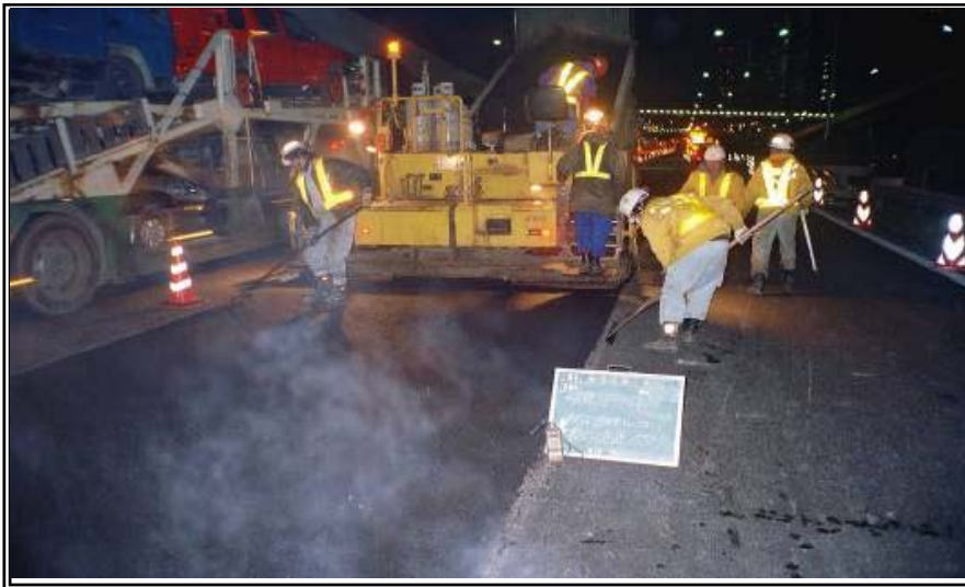
夜間交通規制による施工
