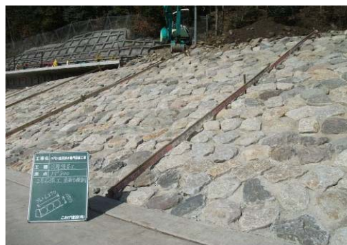
発生材（石）を再利用した護岸
