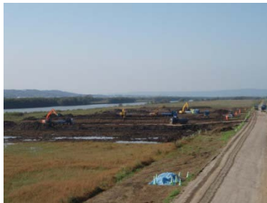
河道掘削施工状況
