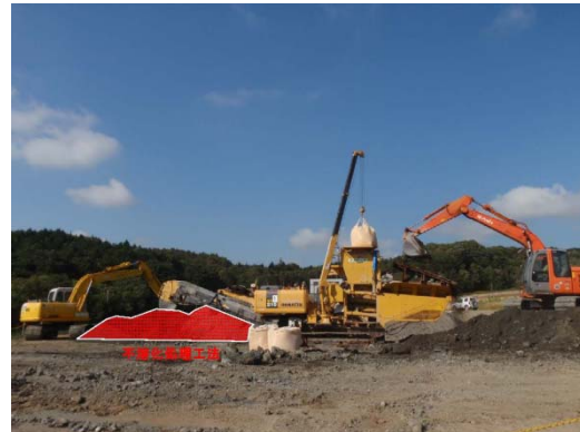
新：不溶化工法
