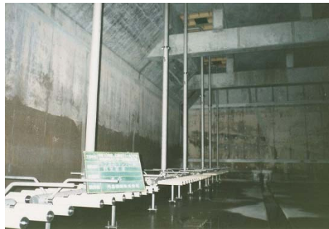
1系反応タンク散気装置
