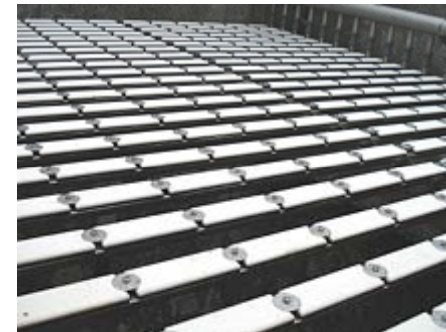
2系反応タンク散気装置例
