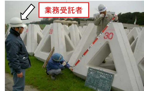
(工事監督支援業務: 根固めブロックの材料確認)
