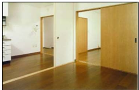
高度なバリアフリー改善及び 状況変化への対応(建具による間仕切り)
