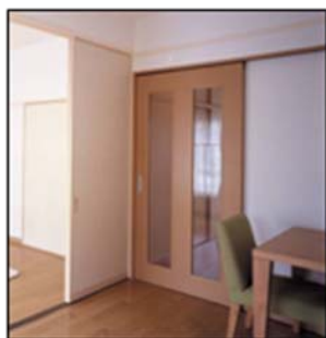
介助車椅子に配慮 した通行幅の確保
