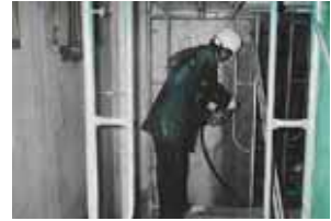
高圧水洗浄工法の例
