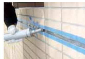
シーリング材の充填
