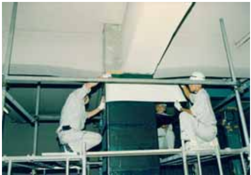
(炭素繊維巻き作業中) (写真出典：マンション耐震化マニュアル)
