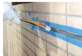
プライマーの塗布
