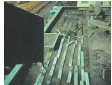
保護層（ブロック）の撤去
