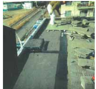
防水層の復旧
