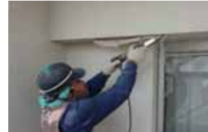
超音波ケレン工法の例
