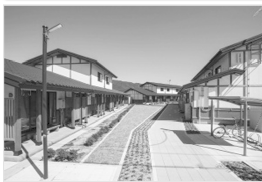
長屋形式の災害公営住宅（岩手県大槌町・70戸）
