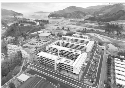
共同住宅形式の災害公営住宅（宮城県女川町・200戸）
