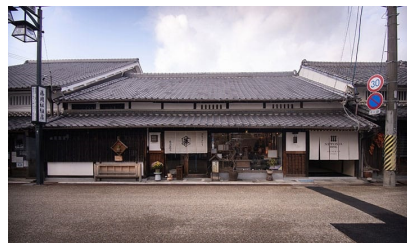
宿泊棟 （個人が所有する空き家を （株）NOTE伊賀上野が改修）
