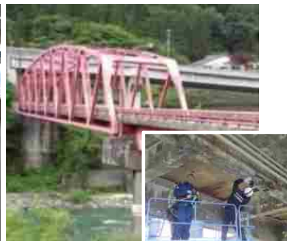
市町村が管理する橋梁の直轄による診断
