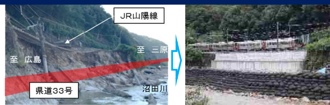
被災直後 復旧後
