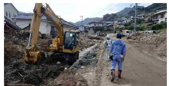
市街地の土砂等の撤去作業を支援
