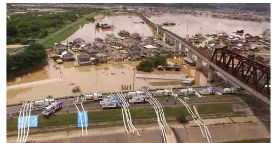
排水ポンプ車23台を集結し24時間体制で排水
