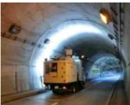
トンネル内を走行し変状写真を撮影
