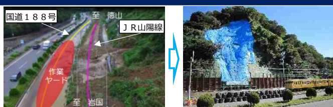
被災直後 復旧後
