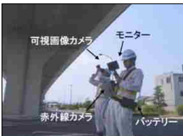
赤外線等によるコンクリートの「うき・剥離」を検査
