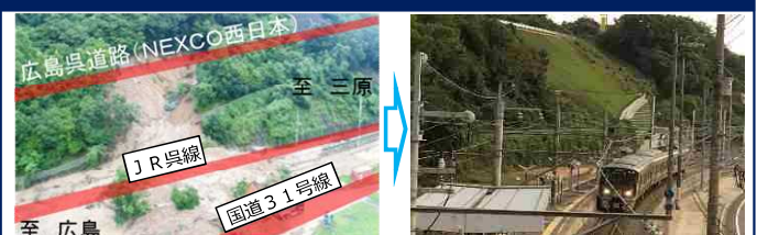
被災直後 復旧後
