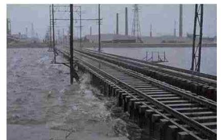
阪神電鉄西大阪線橋梁の状況
