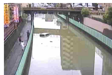
道路 (アンダーパス部) の冠水状況
