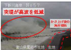
台風第21号による高波来襲時の状況（平成29年10月23日）
