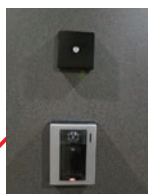
聴覚障害者用の呼び出しボタン(写真上)とカメラ付きインターホン(写真下)
