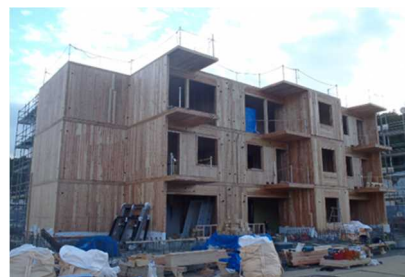
福島県いわき市・57戸(共同住宅)
