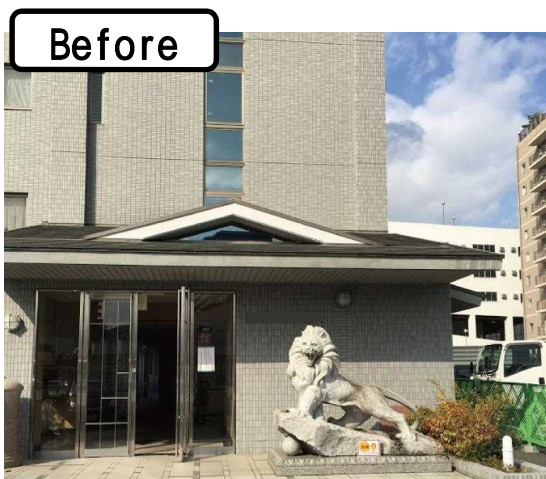
外壁タイル、目地コーキング補修・塗装
