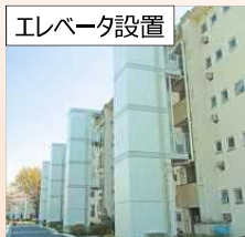
エレベータ設置
