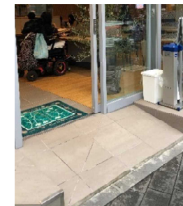
スロープの設置
