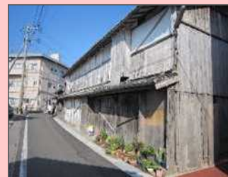
空き家の除却
