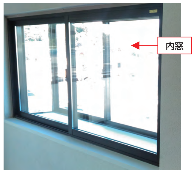
開口部の断熱は、サッシを取り替えるとコストがかかるのでそのままにし、室内側に内窓をつけました。
