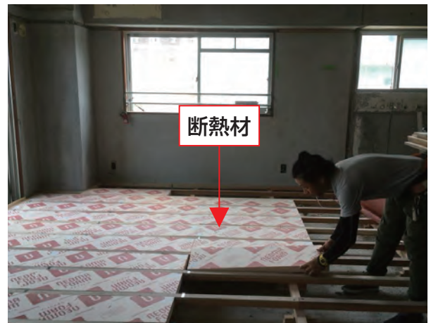
床に断熱材を敷き詰めている
