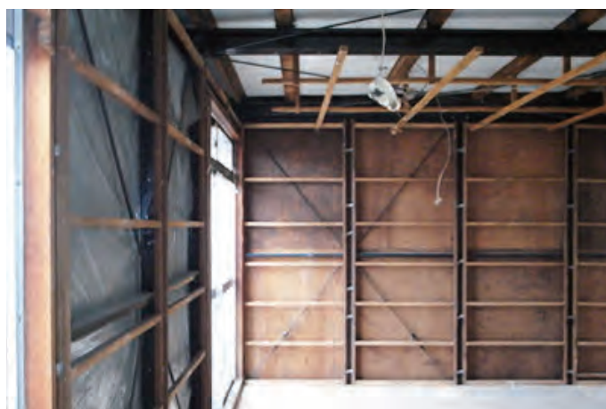
仕上げ材を撤去して、グラスウールを充填する前の状態
