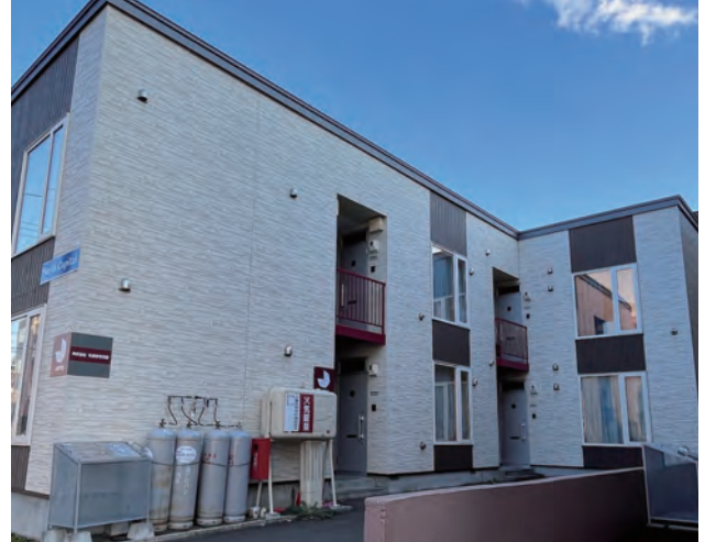
改修後の外観[外装材全面貼替え]
