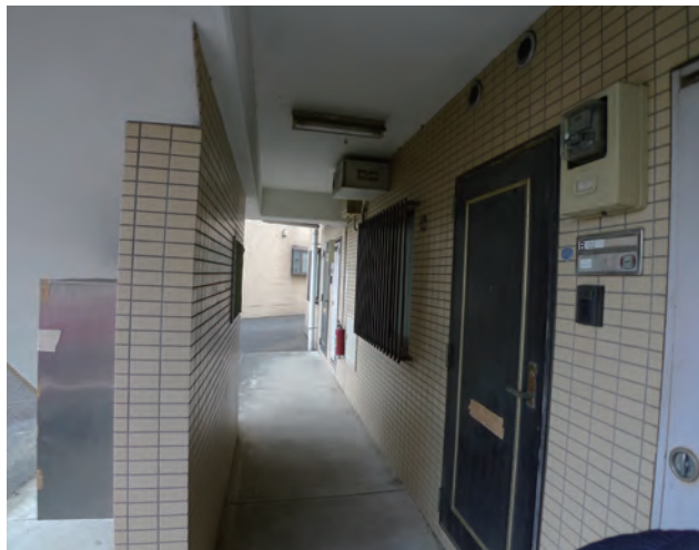
工事前の共用部
