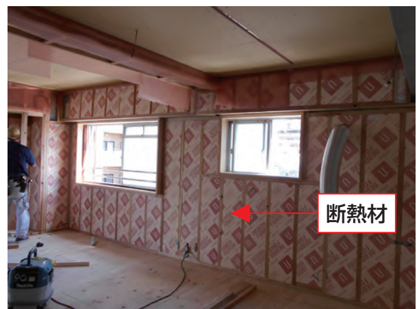
壁に断熱材を充填した状態
