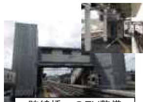
跨線橋へのEV整備 (11人乗、一般形)
