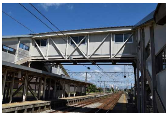
跨線橋(金沢方面側)
