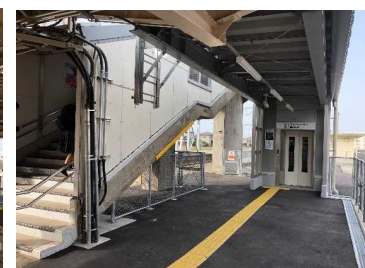
跨線橋側面(1番線側)
