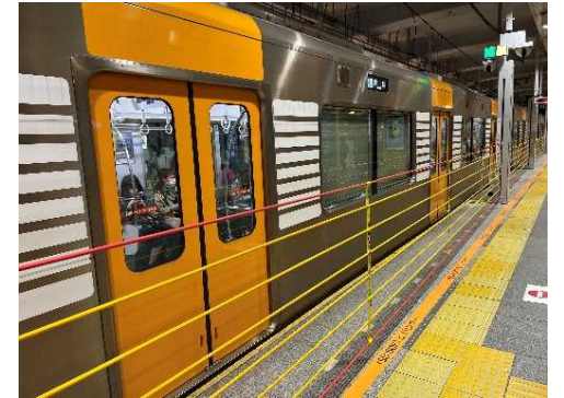
2番線 昇降ロープ式ホーム柵
