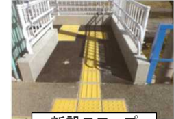
新設スロープ ホーム接続口
