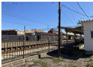
EV跨線橋設置予定場所
