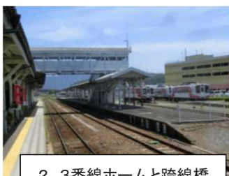
2, 3番線ホームと跨線橋
