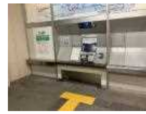
券売機蹴込み改修
