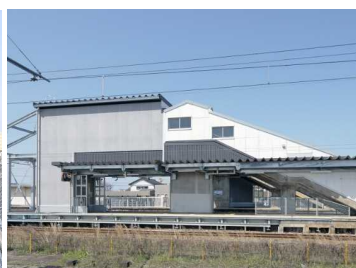
跨線橋側面(3番線側)
