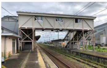
跨線橋(金沢方面側)
