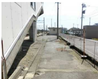
跨線橋側面(1番線側)
