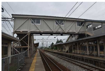
跨線橋(富山方面側)
