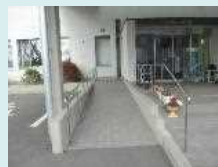
出入口の段差解消 事業費：30万円程度
