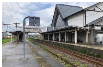
EV跨線橋設置予定場所
