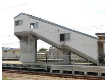
跨線橋側面(3番線側)
