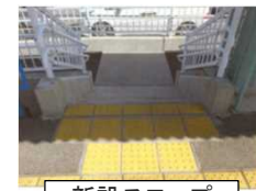
新設スロープ 階段
