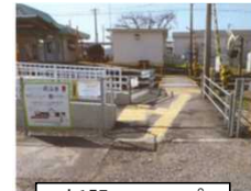
新設スロープ 上り口
