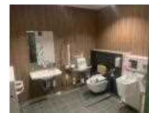
バリアフリートイレ新設
