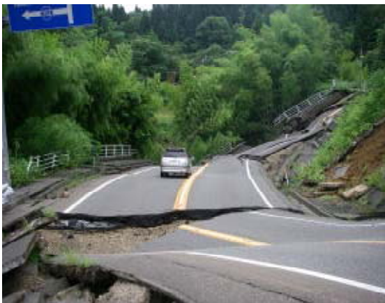
国道8号長岡市大積千本町
