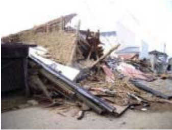
倒壊して道路交通を遮断した古い木造家屋
