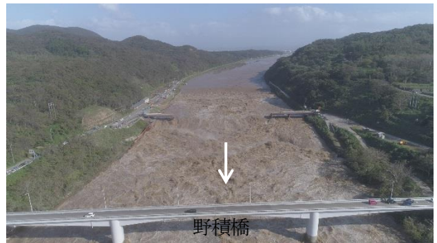
図-1 出水時の野積橋付近の状況
