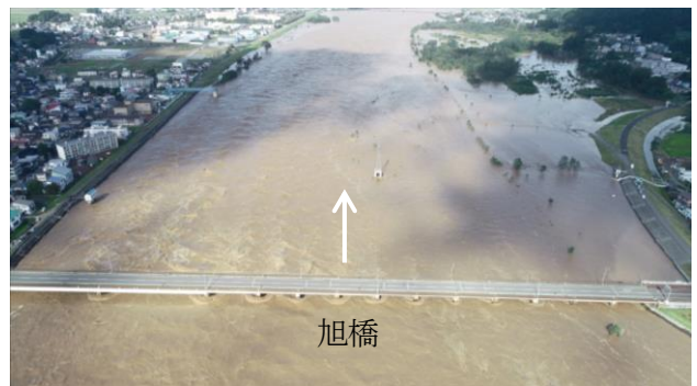
図-2 出水時の旭橋付近の状況
