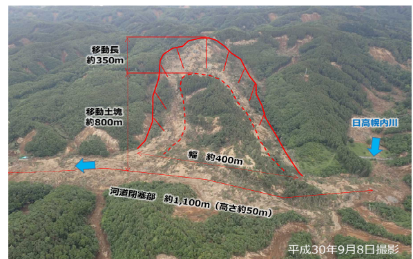
図-2 大規模河道閉塞（日高幌内川）
