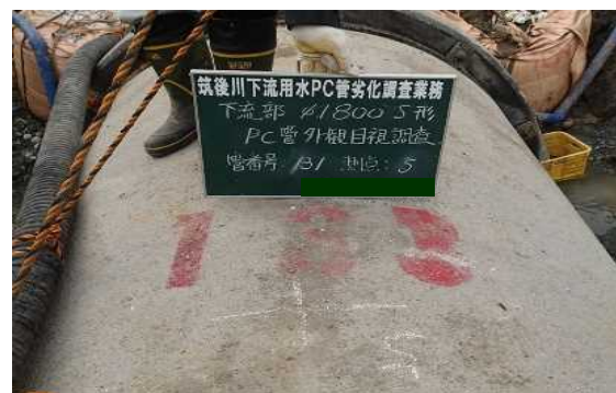
写真-2 管表面のマーキング状況
