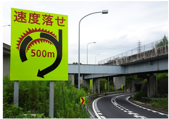
写真4 曲線入口部大型警戒標識
