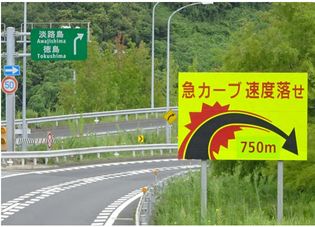
写真3 C300付近 大型警戒標識
