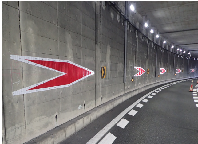
写真6 ボックスカルパート内 線形誘導標
