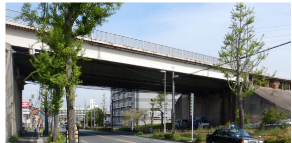
写真-1 橋梁全景 (右がA1橋台-起点側)
