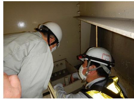
写真-8 合同現地調査状況
