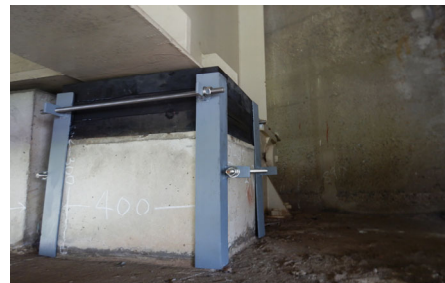
写真-11 緩衝ゴム設置
