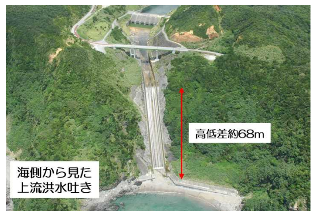
図-1 福地ダム上流洪水吐き
