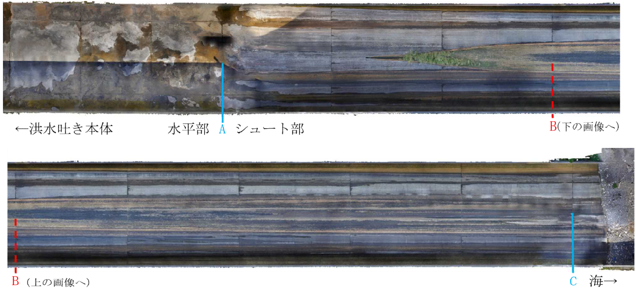
図-4 作成したオルソ画像 (抜粋：シュート部床板)
