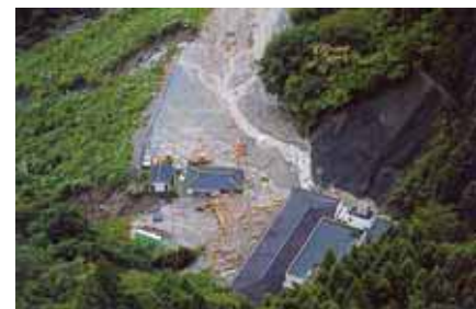
写真-2 ホテルの被災状況
