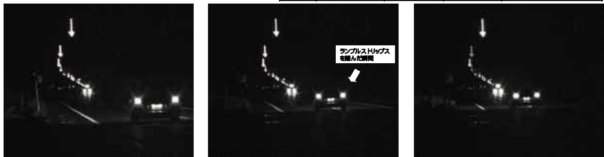
車がセンターラインに寄っていく ランブルストリップを踏む あわてて車線に戻る 写真 - 3 . ランブルストリップにより大型車との正面衝突事故を防いだ場面
