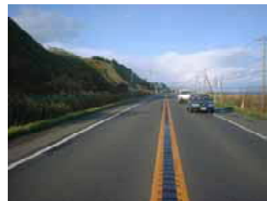
写真 - 2 . ランブルストリップス設置状況
