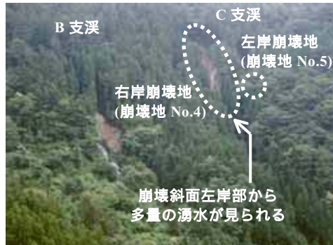
写真-3 崩壊発生翌日の B・C 支溪崩壊地周辺の状況 (撮影日：1999年6月30日)
