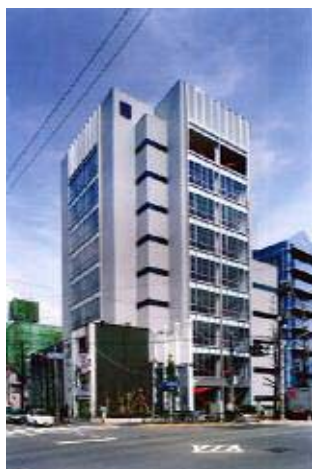
図3 対象建物の概観
