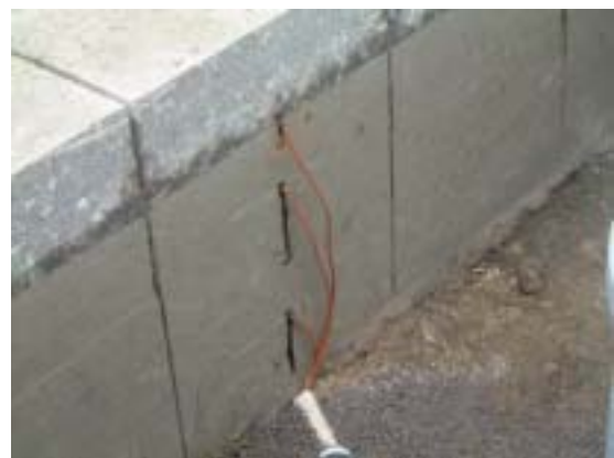
写真-1 温度計の設置状況
