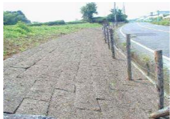
写真-3 バイオマスボードの従来工法
