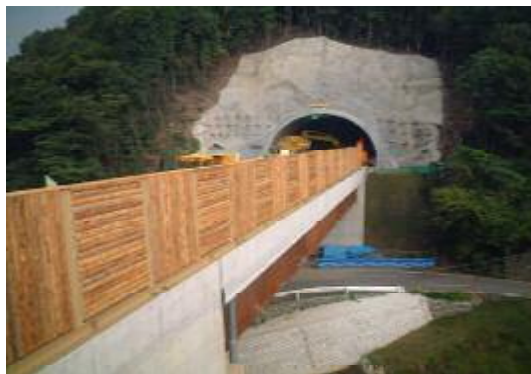
写真－2 現場活用例(仮設遮音壁)
