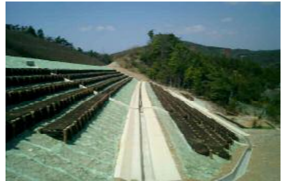
写真-4 バスターボード布設状況
