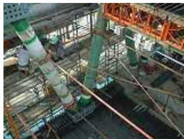
写真 - 6 斜材仮固定状況
