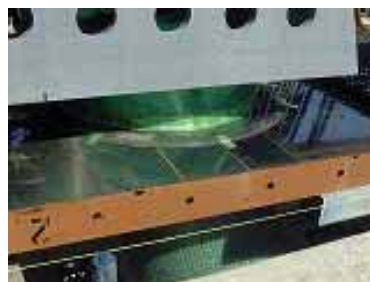
写真 - 9 斜材出口の型枠処理材
