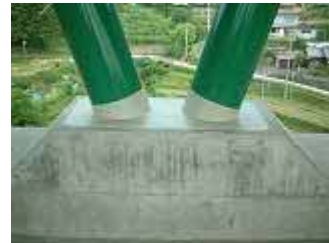
写真 - 10 ウレタン防水工
