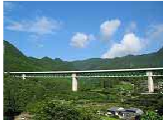
写真 - 1 木ノ川高架橋
