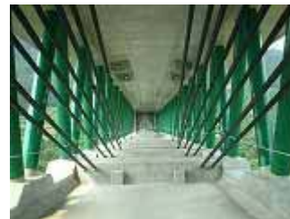
写真 - 2 主桁内部
