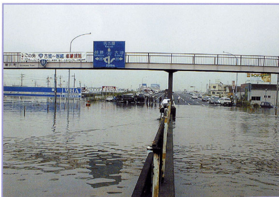
国道22号 新川町(路面冠水)
