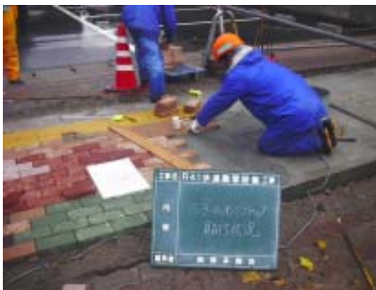
図 3-4 施工状況（高熱伝導 ILB）
