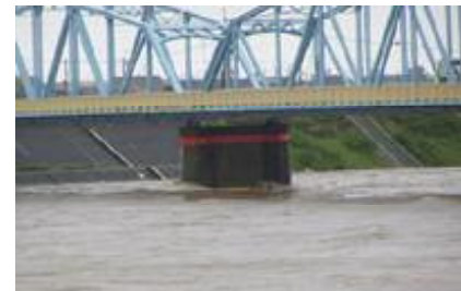
H15. 5. 31台風4号による出水状況（古庄観測所）
