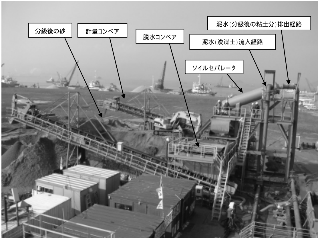
写真 - 1 分級工事の写真
