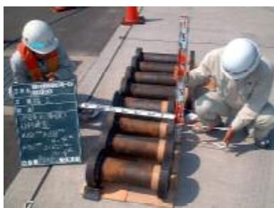
吊鉄筋確認状況
