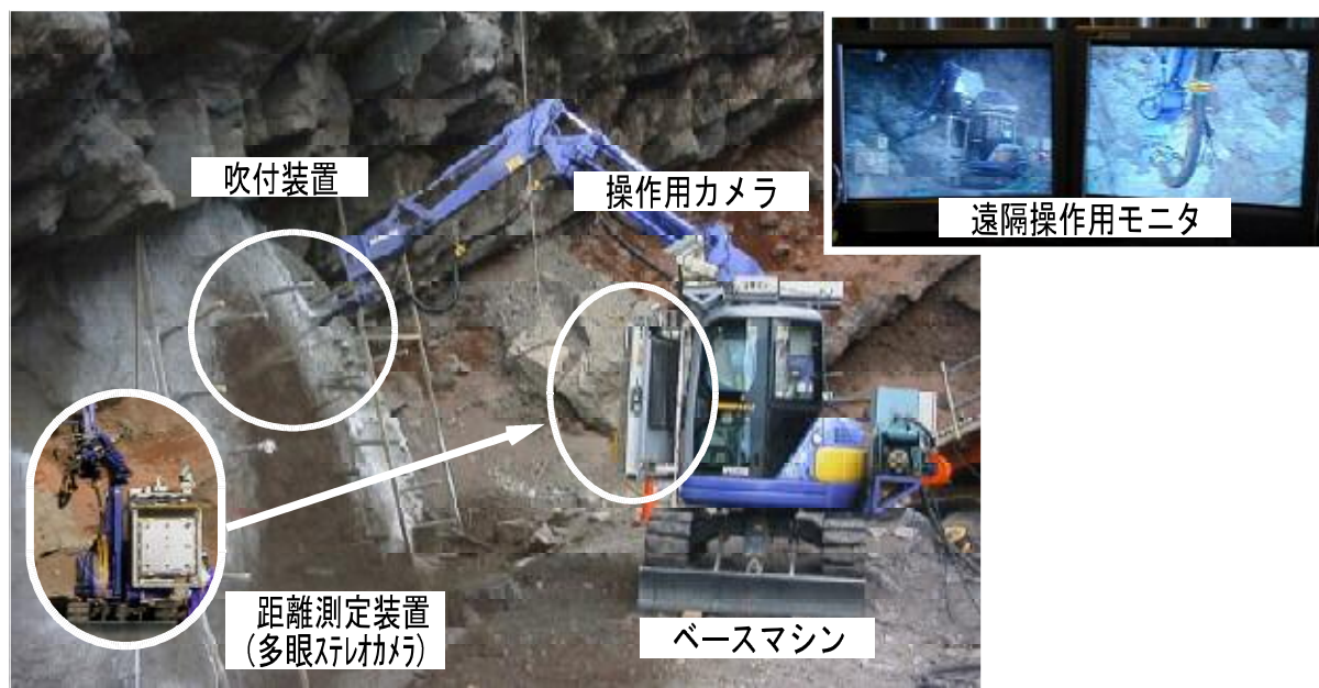
写真-3 吹付システム
