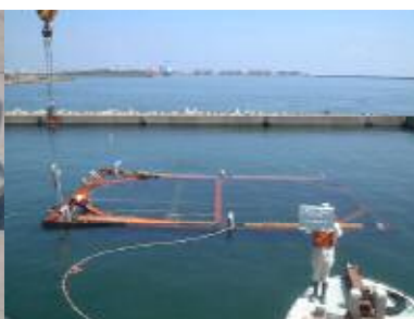
止水壁設置状況
