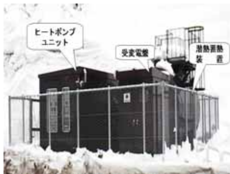
写真-2 消融雪設備全景
