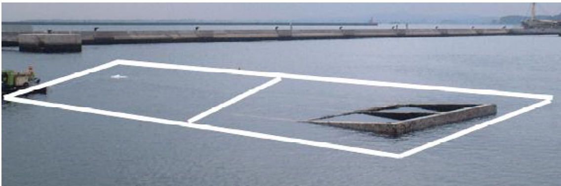
ケーソン仮置状況（干潮時）
