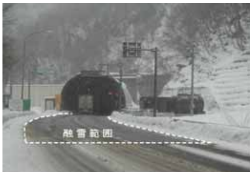
写真-2 路面状況(トンネル坑外H15.1.15)
