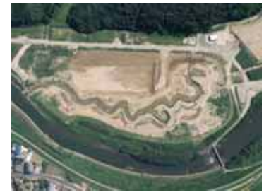
図 - 11 現地掘削状況
