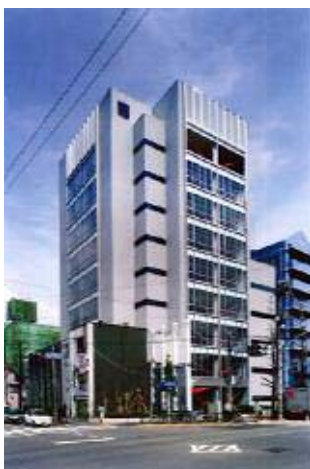
図3 対象建物の概観
