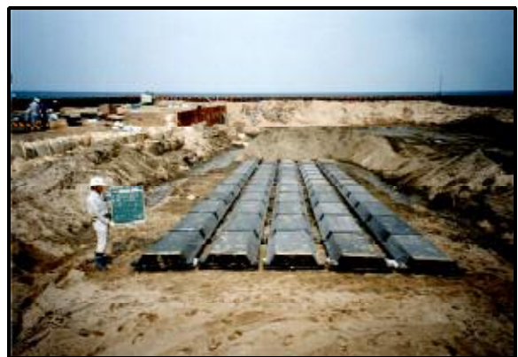
写真-2 透水層設置状況
