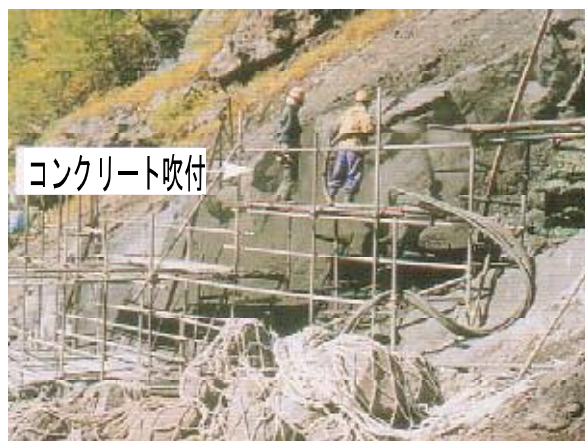
写真-2 人力によるコンクリート吹付状況
