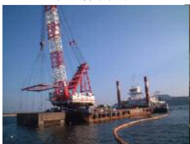
浮函完了状況
