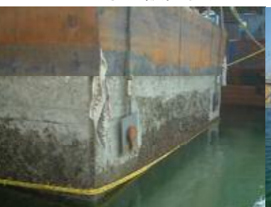
止水壁・吊鉄筋状況
