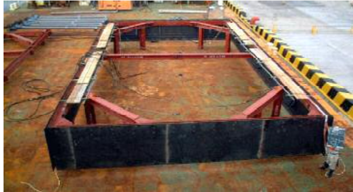
止水壁組立完了状況
