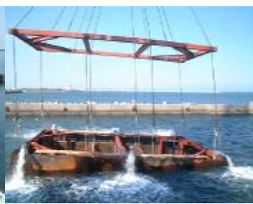
排水・浮函状況
