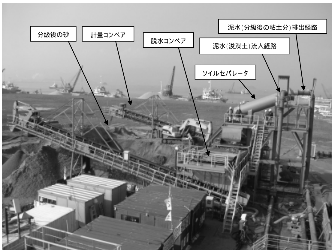
写真 - 1 分級工事の写真
