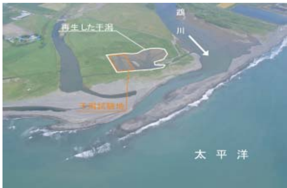
写真 - 5 再生した干潟（H15年7月29日撮影）
