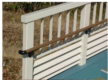
写真-8 横断歩道橋手摺
