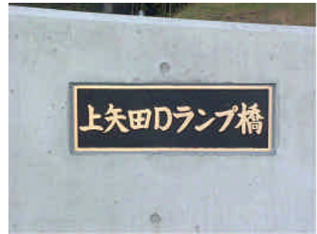
写真-7 橋名板(上矢田Dランプ橋)
