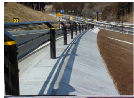
写真-11 プレキャストブロック設置状況
