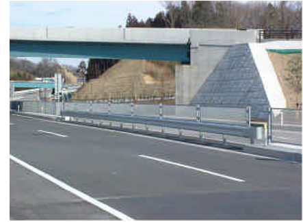
写真-10 着脱式防護柵
