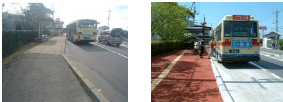
Photo.2 バス停車帯切り込み形状 改良前後
