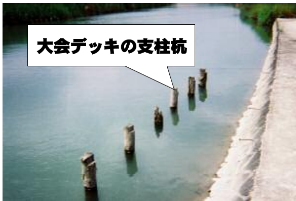
写真-2 現況低水護岸
