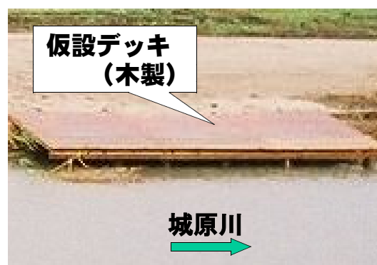
写真-4 仮設デッキ
