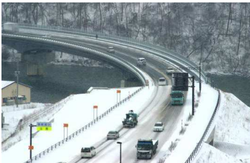
写真2 橋梁のロードヒーティング
