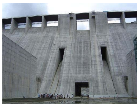
写真-4 仮排水路
