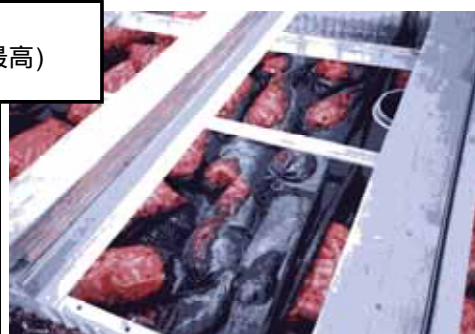
写真-7 接触酸化槽 嫌気化の状況
