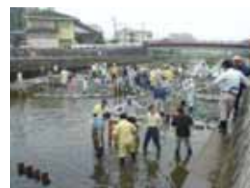
写真 - 7 浄化材設置状況
