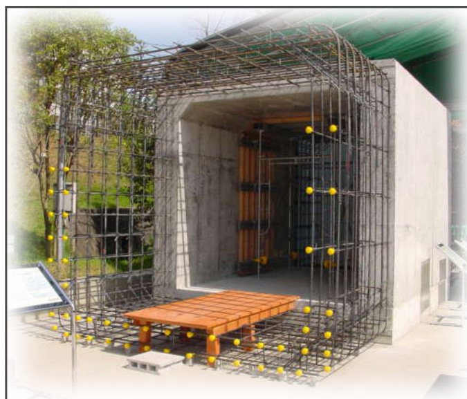
写真-3 人道ボックスカルバート
