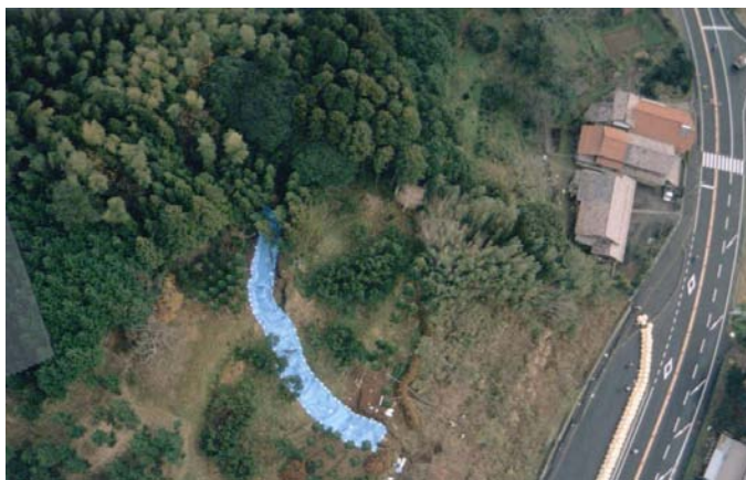
写真-1 仙山峠地すべりの全景
