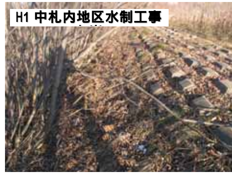
図 - 5 覆土のない護岸
