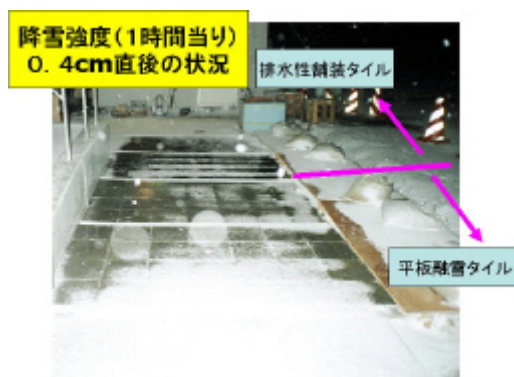
写真 - 6 独立型の実験施設及び融雪状況
