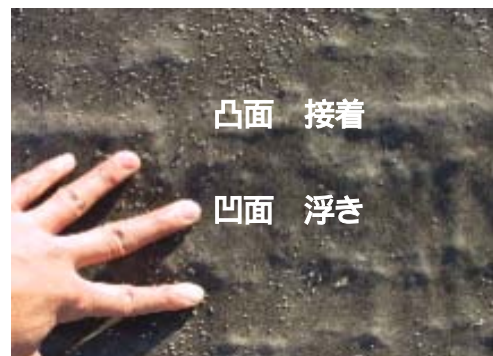
写真3 床版防水Bの凹凸追従性
