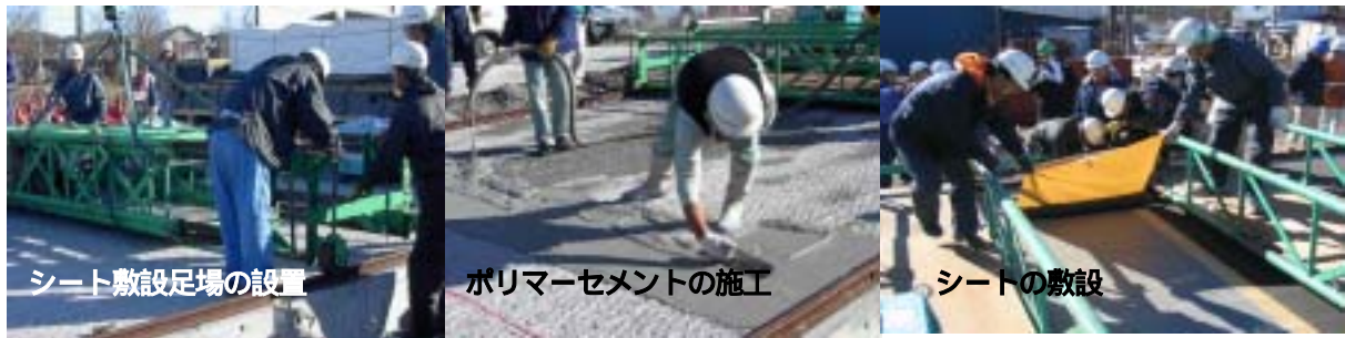
写真2 床版防水Fの施工状況
