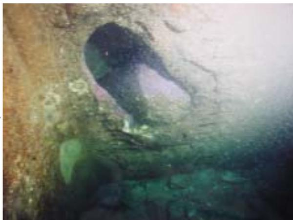
図1-1 ケーソン損傷状況（穴あき）
