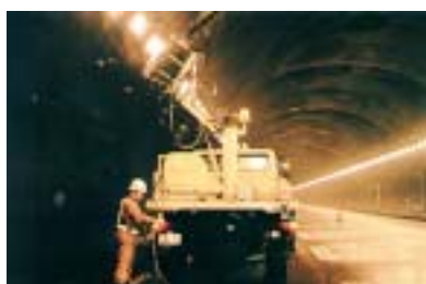
写真 - 2（回転ブラシ方式によるトンネル照明灯具の清掃）
