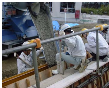
写真-2 打設状況 (フィールド実験)
