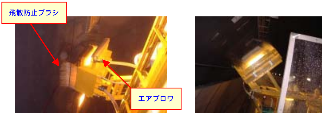
トンネル照明灯具洗浄状態
